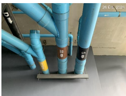
รูปที่ 24 ท่อรวบรวมน้ำห้องพักมูลฝอยเข้าสู่ระบบบำบัดน้ำเสียของโครงการ
