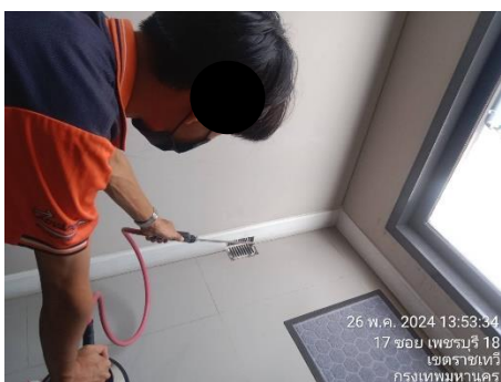
รูปที่ 24 ท่อรวบรวมน้ำห้องพักมูลฝอยเข้าสู่ระบบบำบัดน้ำเสียของโครงการ
